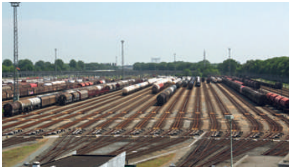
Opstelsporen na het heuvelen voor samenstelling van de vertrekkende treinen.
